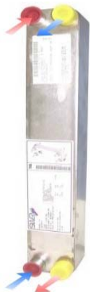
超效能板式熱交換器
